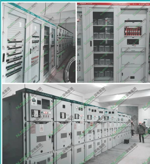
周口河畔小区智能辅助监控系统
