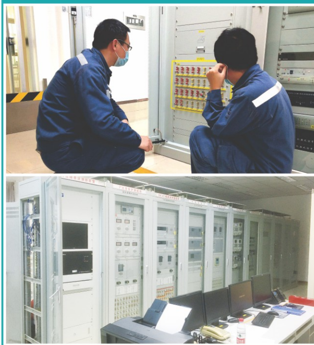
内蒙古开鲁城镇66kV 10KV过渡变电站
